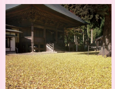
薬王寺薬師堂 福島県東白川郡塙町 大字台宿字大久保53
