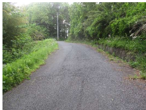
（林道舗装補修工測量）
