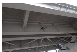
ドローンによる桁下の点検
