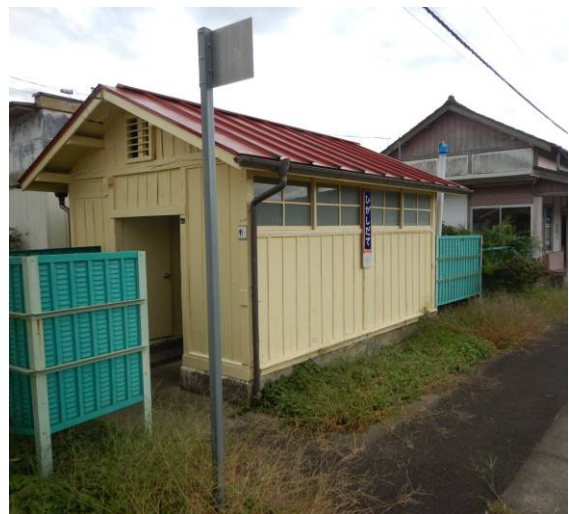
公衆トイレホーム側出入口
