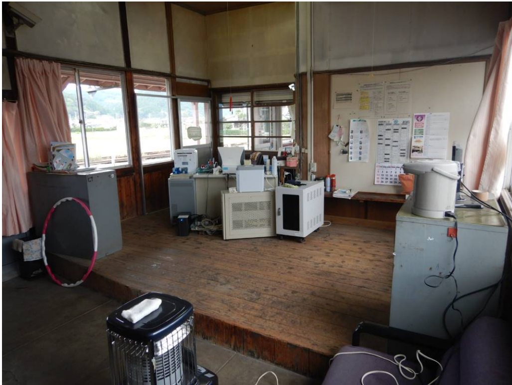
事務室部分（床嵩上げ）
