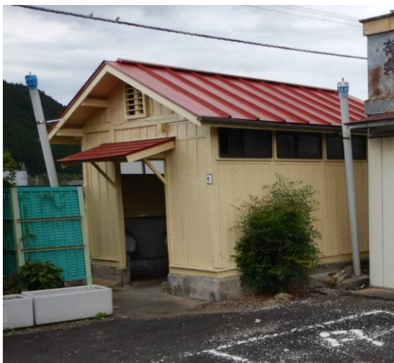
公衆トイレ外側出入口
