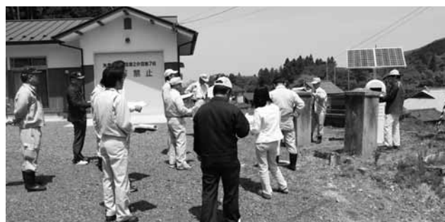
放射線測定ポスト設置状況（大槻地内）
