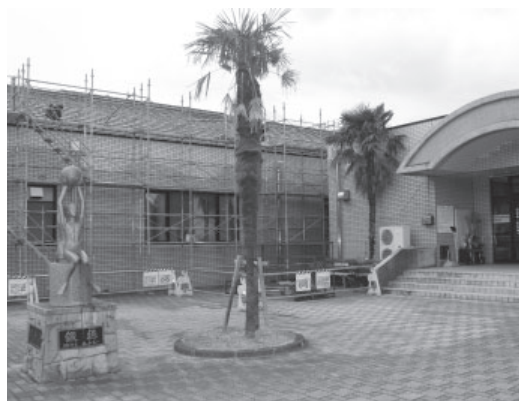
▲管理棟や屋上ダクト、外壁の一部などの改修を行っており、入口付近に足場が組まれているためお子さんをお連れの利用者の方は特にお気を付けてください。
