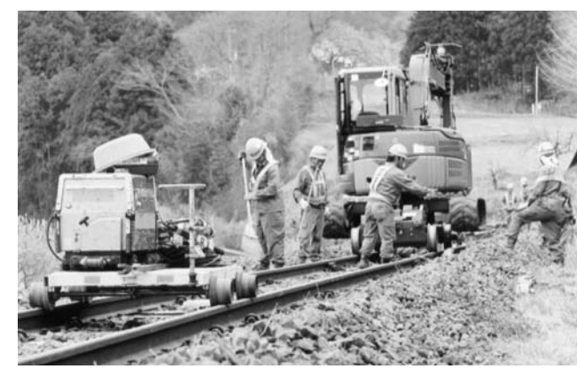
レールの修復作業
