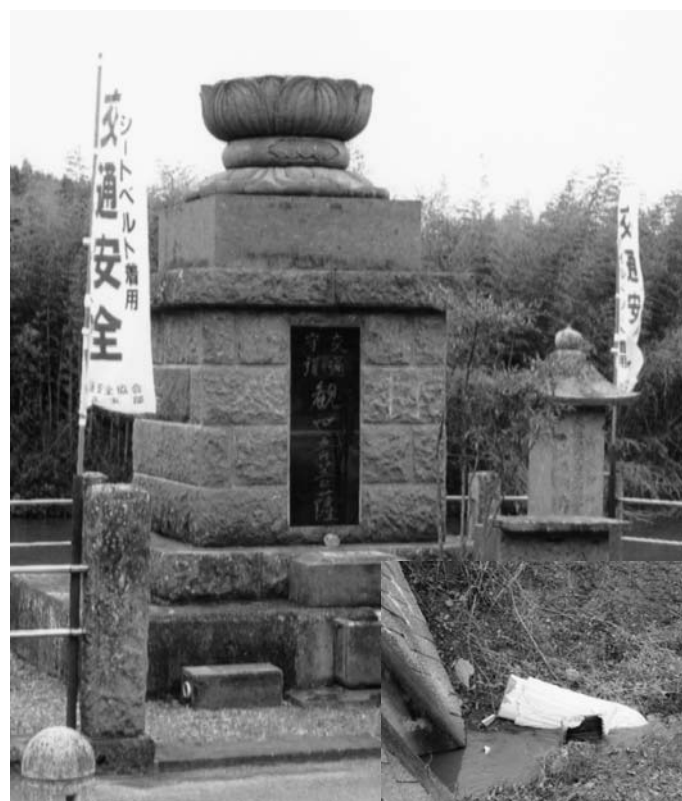
交通守護観世音菩薩像の倒壊
