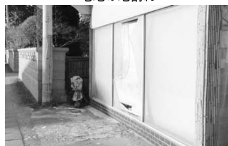
窓ガラスの損壊
