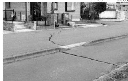
宅地の地割れ
