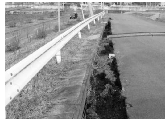
道路の地割れ
