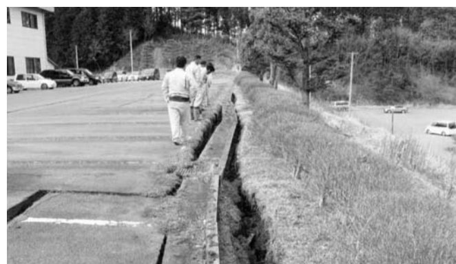
敷地の地割れ
