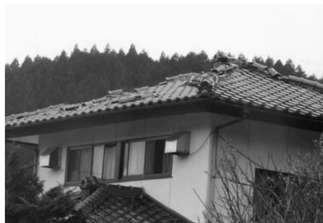
屋根瓦の崩落
