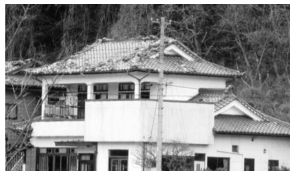
屋根瓦の崩落
