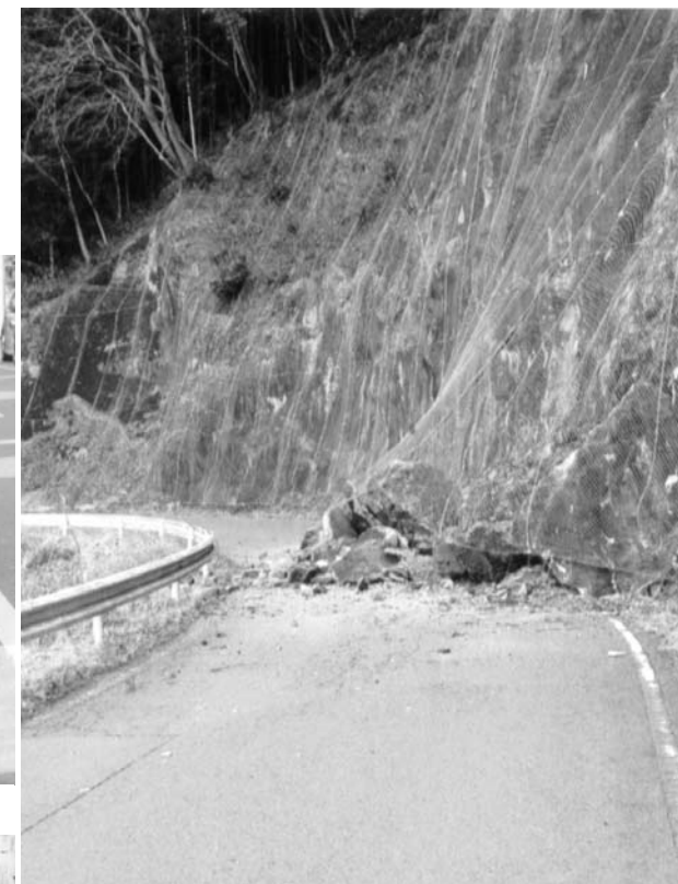
法面の崩れ(町道)
