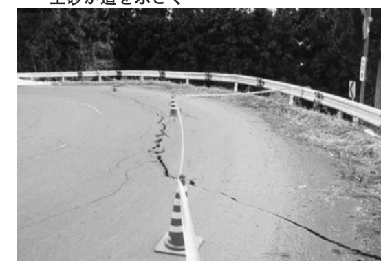
町道の地割れ
