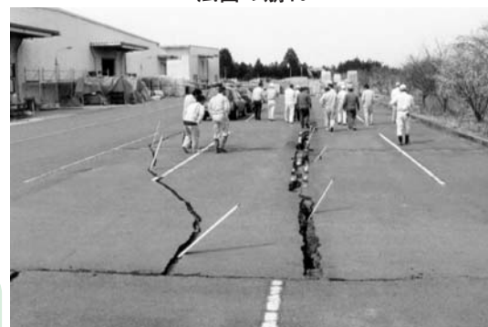
敷地の地割れ
