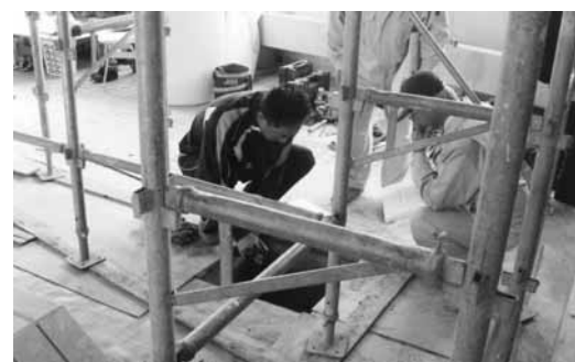
▲町民プール 屋内プール補修工事
