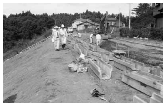
▲道路災害復旧工事（矢祭ニュータウン）
